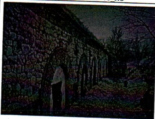
Слика 18. Зајечарски бастioni Извор:
